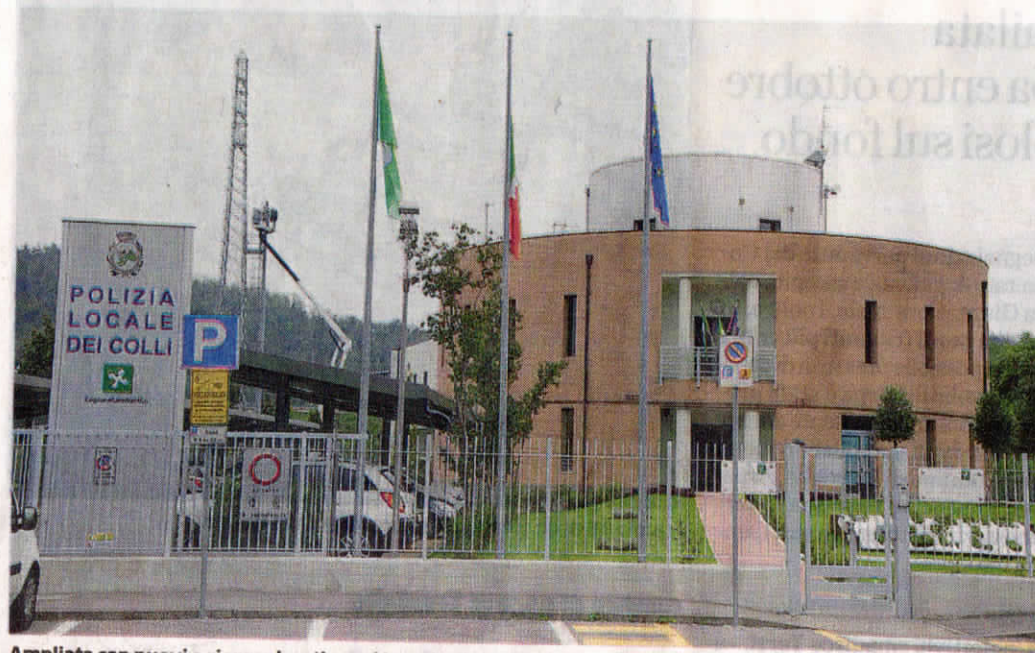
Ampliata con nuovi e riorganizzati spazi la sede di Albano dell'Unione intercomunale dei Colli FOTOBORG
