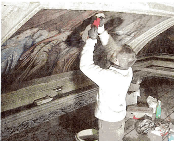
Pulitura e pre consolidamento di una volta affrescata
