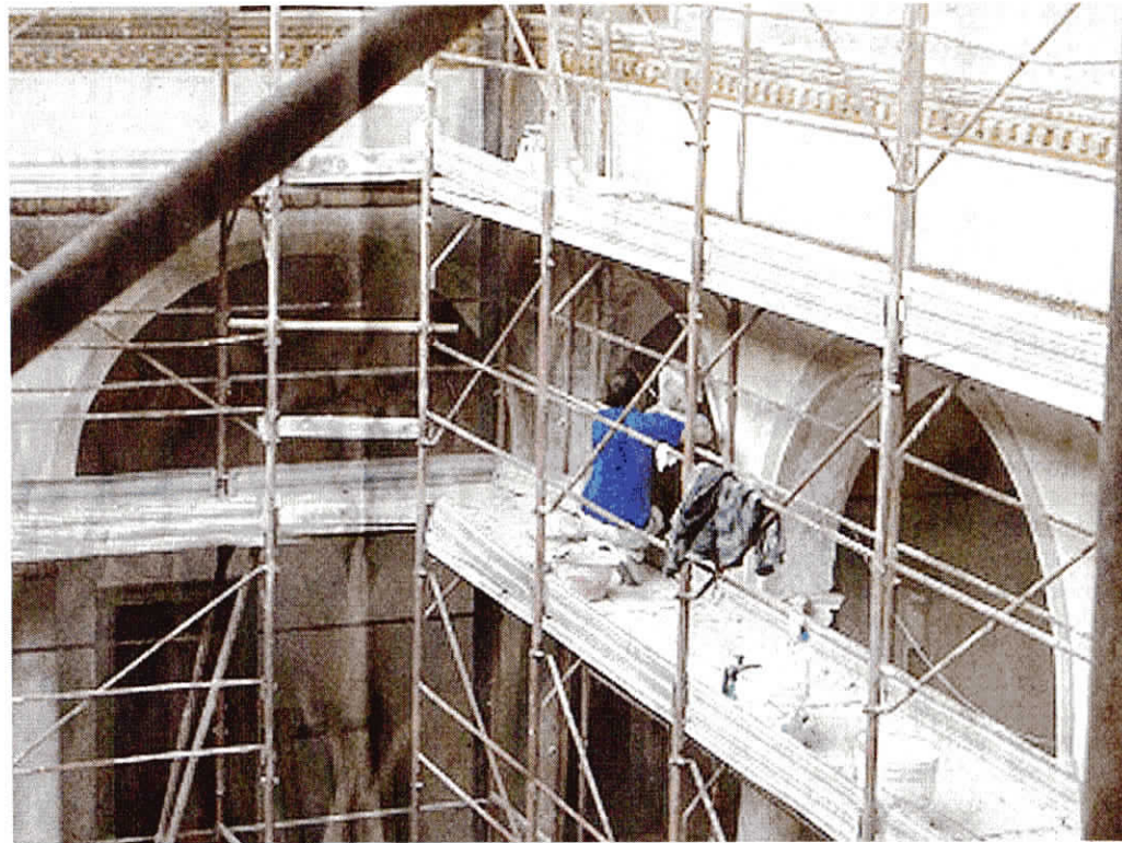
Lavori di restauro e consolidamento di intonaci e cornicione in cotto delle facciate del chiostro minore
