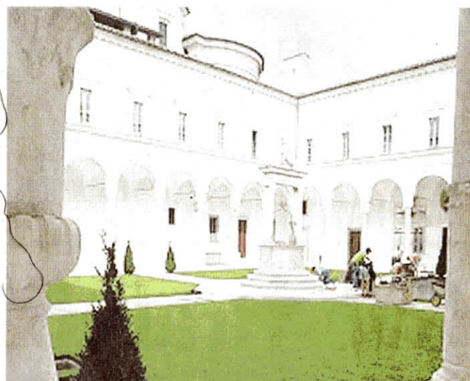
Posa del manto erboso nel chiostro maggiore dopo il restauro
