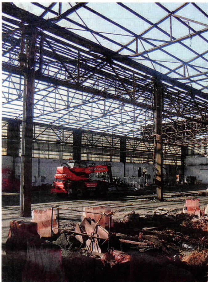
I lavori di bonifica delle ex Fonderie, fermi da qualche mese
